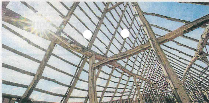
Freier Blick durchs Dach des Rössen-Hauses. Es wird im kommenden Jahr noch gedeckt.
